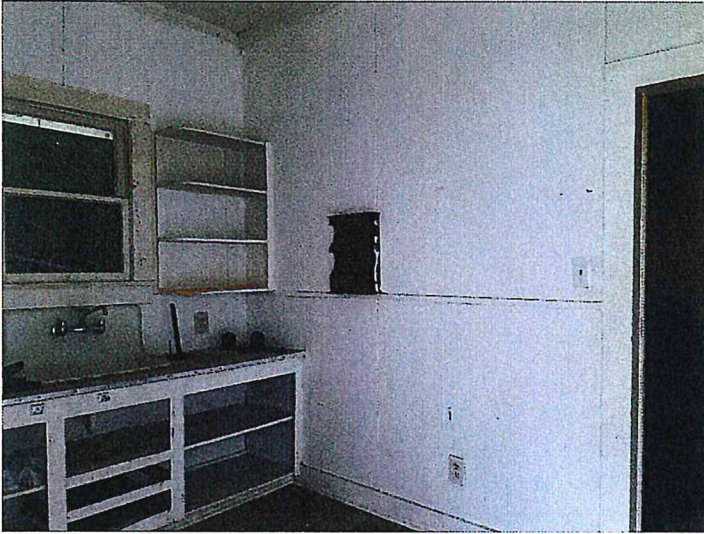
4/19/2016 513 A&B - INTERIOR B SIDE Pic (13).jpg
