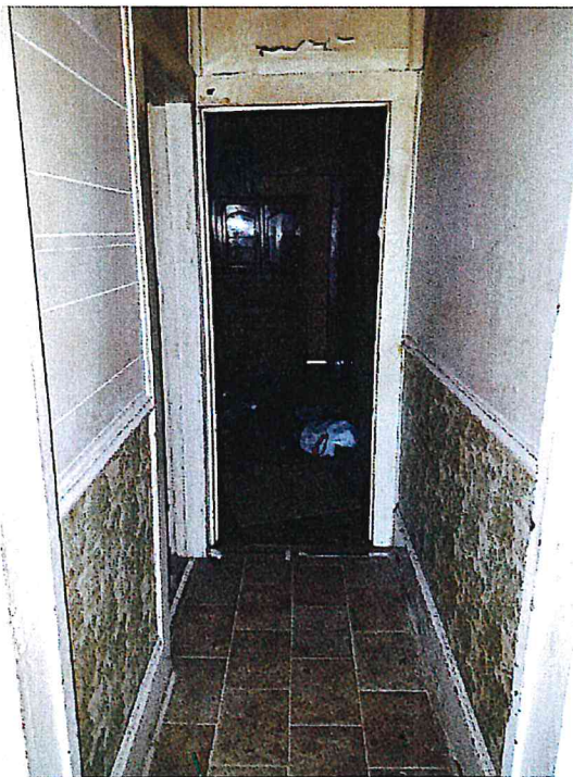
4/19/2016 513 A&B - INTERIOR B SIDE Pic (15).jpg
